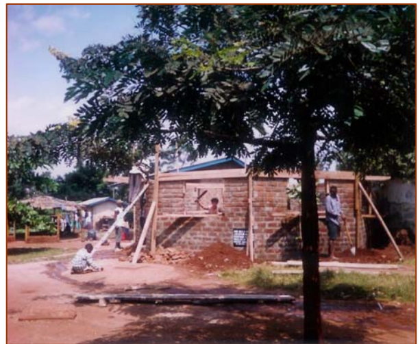
Réfectoire en construction
